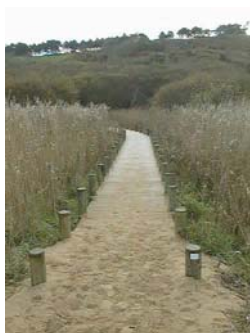
Photo 9 : exemple de platelage
