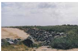
Photo 2 : enrochement à Meuvaines
