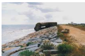
Photo 10 : « cordon-digue » de la Brèche de Bisson
