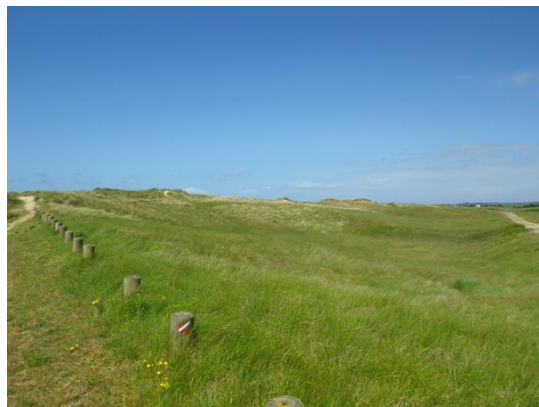
Figure 65. Canalisation des piétons et fermeture des accès aux véhicules par plots - Dunes de Portbail
