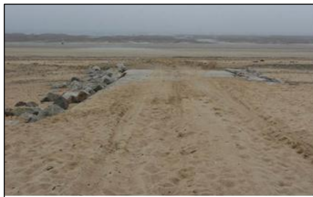
Figure 43. Rampe d'accès bétonnée et renforcée avec des enrochements sur la plage à Saint-Georges
