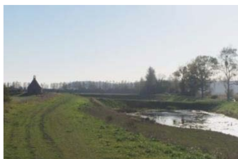
La chapelle Sainte-Anne après travaux
