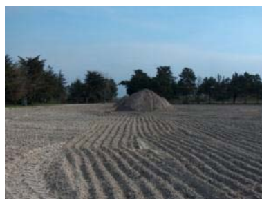
Travaux de restauration
