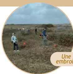
Installation de ganivelles
